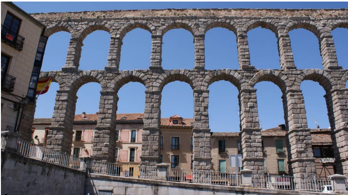
Ilustración 30 Fotografía arcos del acueducto de Segovia zona 4.
