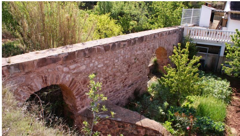
Ilustración 62 Acueducto de Gatova, Valencia.
