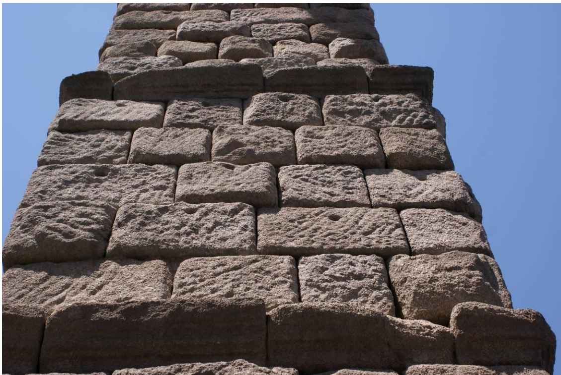
Ilustración 37 Fotografía sillares del acueducto de Segovia.
